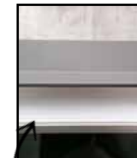
Jonc de finition en partir basse du dormant
