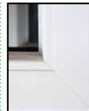
Soudure grain d'orge sur la face intérieure. Assemblage en coupe d'onglet.
