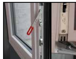
Compression et sécurité doublée grâce à la crémonne du semi-fixe en cas d'oscillo battant
